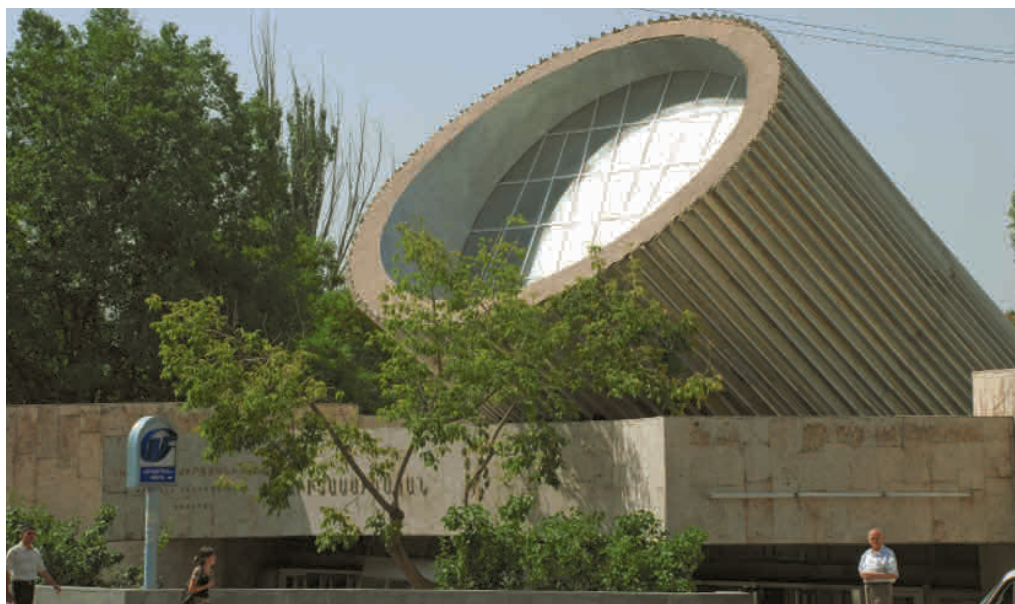
Rénovation du réseau métropolitain de Yérévan, Arménie
