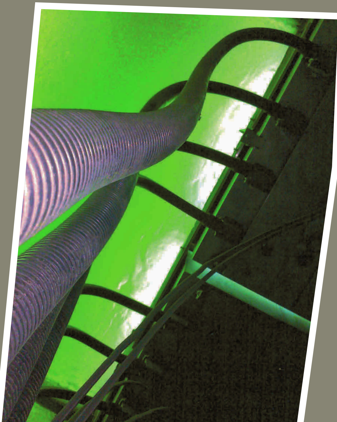
Canal de désinfection par UV à la station d'épuration du sud-ouest à Saint-Petersbourg (Russie)
